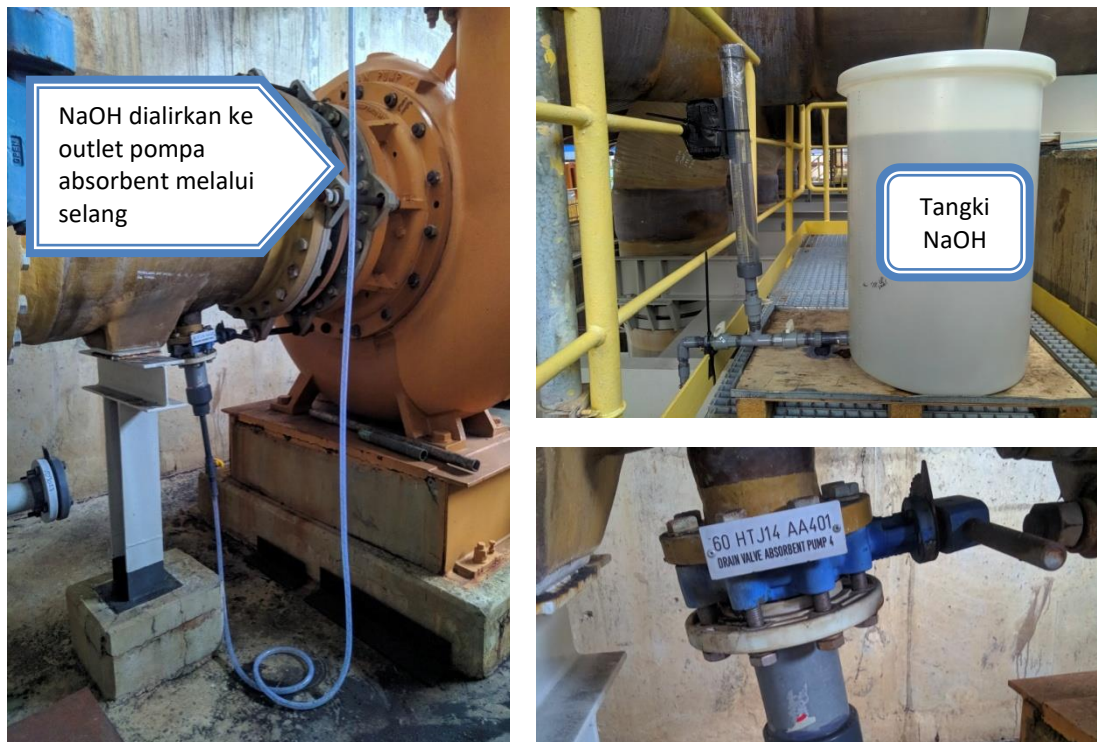
Gambar 3. Foto-foto implementasi injeksi NaOH pada FGD Unit 6
